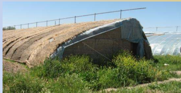
Ночная теплоизоляция теплицы из камышовых матов
