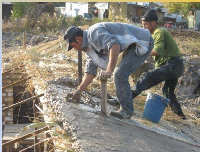
Укладка теплоизоляции из камыша и заливка крыши
