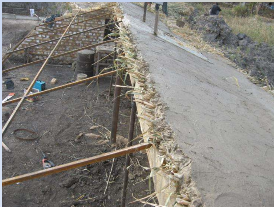
Утепление крыши камышом
